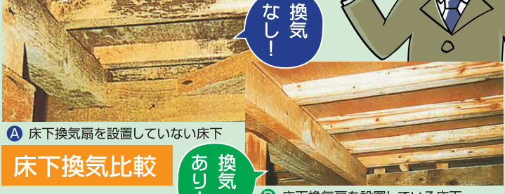
A 床下換気扇を設置していない床下
