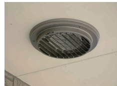
軒天用丸・平換気口 (丸穴取付) N-125STV2-A3
