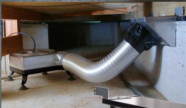
従来の床下換気扇では取付けることのできなかった基礎バックリング工法の住宅でも、専用のスリムノズルを装着することで簡単に取付けることができます。（オプション）
