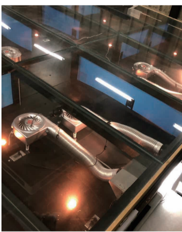
■ブロー型換気扇設置
