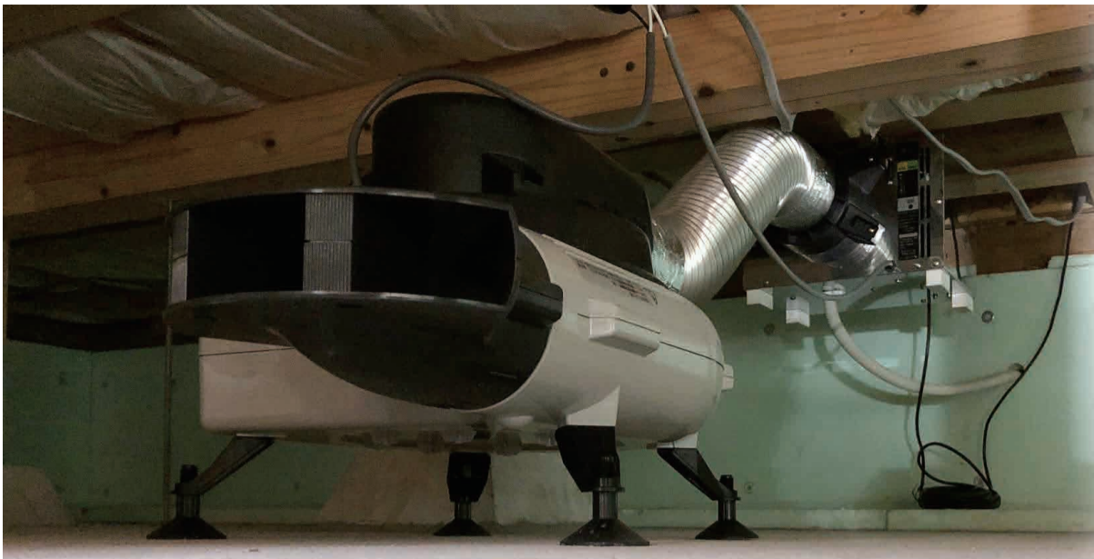
■床下除湿送風機「ドライ・プロ」効果検証 テストハウスA棟に設置し、温湿度の計測と木材含水率の計測を行いました。
