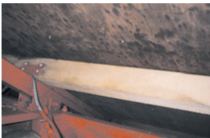
▲換気が悪く小屋裏に発生した黒カビ
